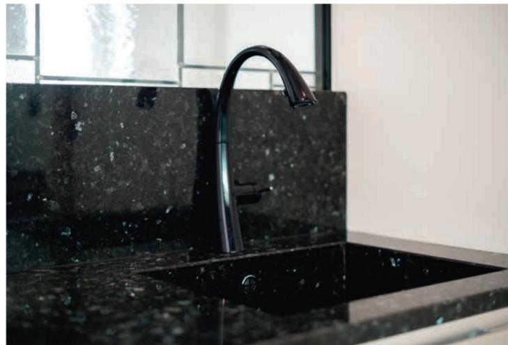
La cuve, grâce à un assemblage spécial à 45°, affiche le même revêtement en granit Labrador vert que le plan de travail et le dossier. Quant au mitigeur, il vient adoucir de ses lignes courbes la rigueur de la composition, tout en optant pour une robe noire harmonieuse avec son environnement direct.
